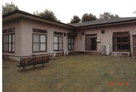
工事完了(同日)
